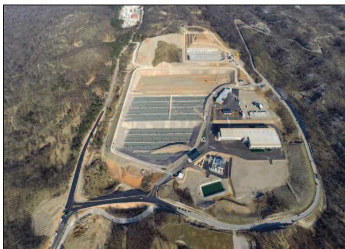
Slika 6. Postrojenje mehaničko-biološke obrade u ŽCGO Marišćina (izvor: http://www.ekoplus.hr )
