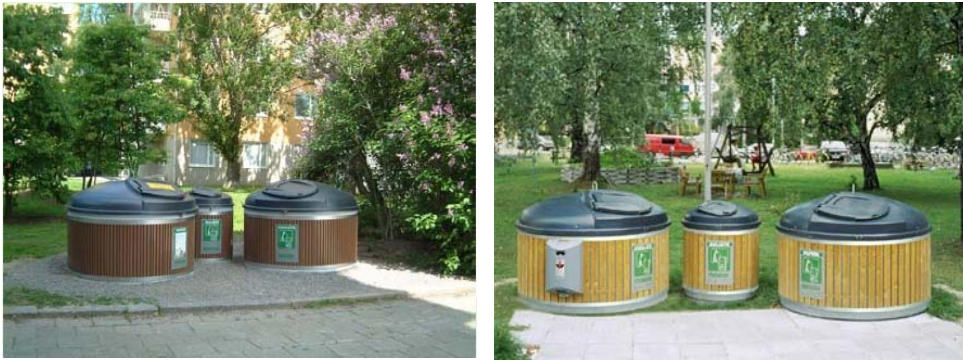
Slika 15: Podzemni sustav spremnika u prostoru
