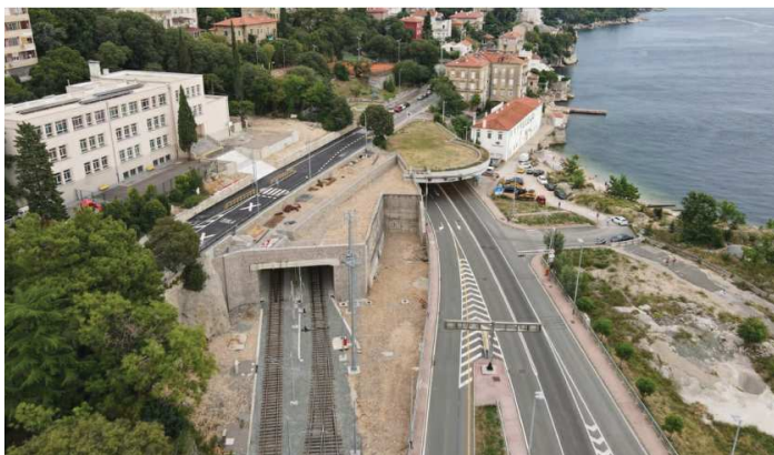
Slika 8. Pogled na novoizgrađeni tunel Sušak
