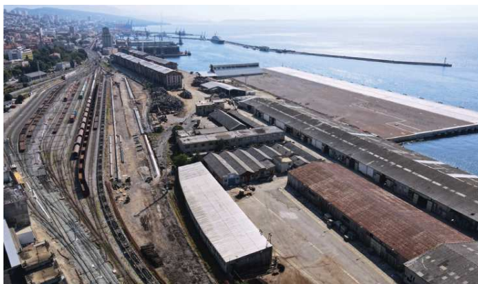
Slika 9. Radovi na željezničkoj infrastrukturi (lijevo), terminal Zagrebačka obala (desno)
