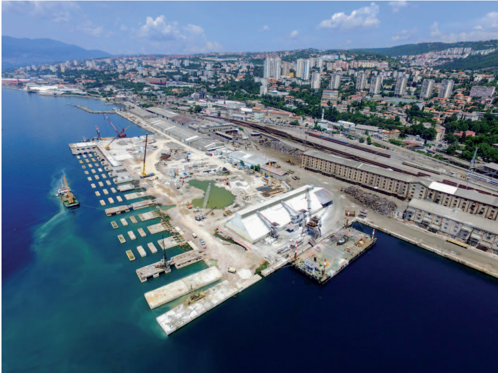
Fotografija 2. Pogled na izgradnju novoga kontejnerskog terminala na Zagrebačkoj obali
