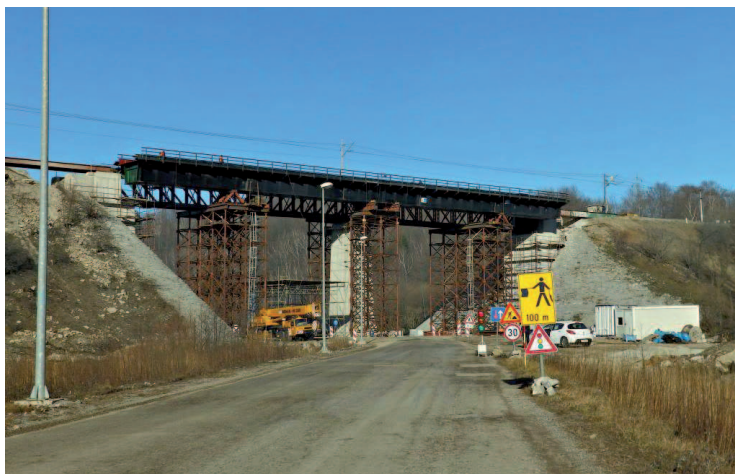
Fotografija 1. Rekonstrukcija željezničkog mosta Ličanka
